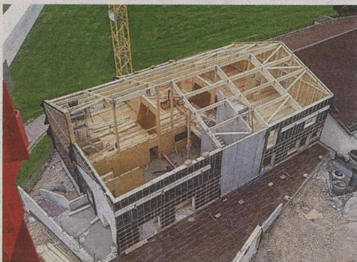
Un puzzle d'éléments préfabriqués isolés en paille conçu par l'entre prise Yvon Boillon.
